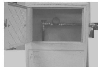
EXEMPLE D'ARMARI AMB SÒCOL DE FORMIGÓ
