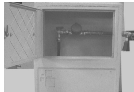
EXEMPLE D'ARMARI AMB SÒCOL DE FORMIGÓ
